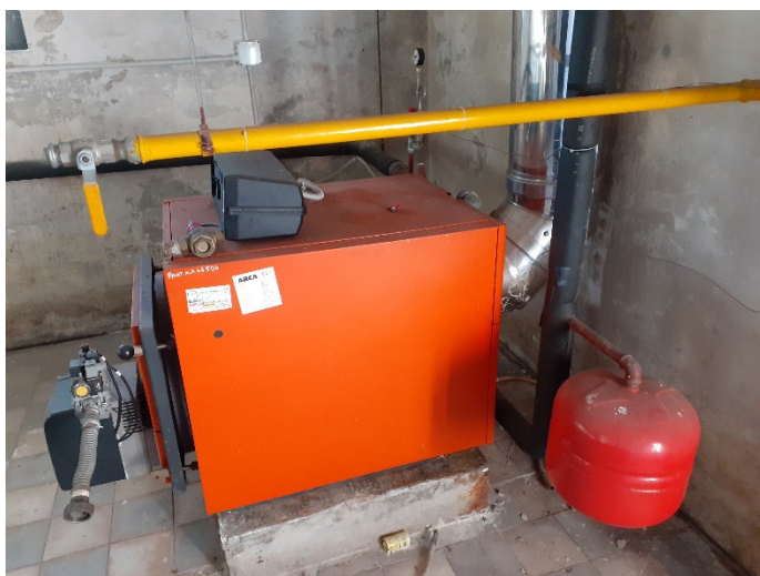
Caldaia da sostituire
